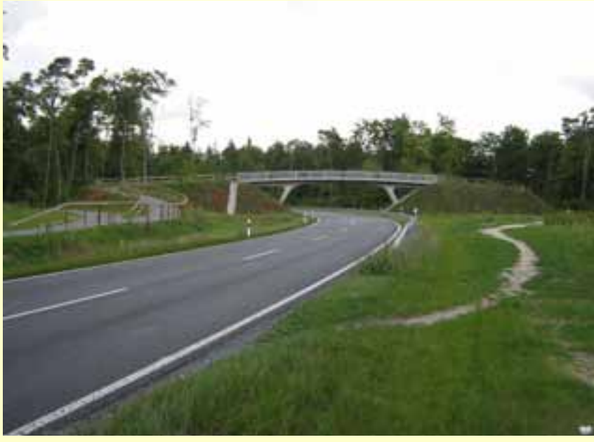
Einschleppung beim Bau einer Umgehungsstraße 2008
